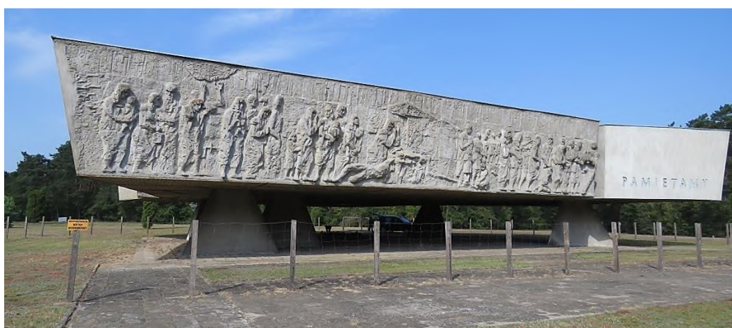
Widok pomnika od strony drogi wojewódzkiej DW473. Elewacja wschodnia.
