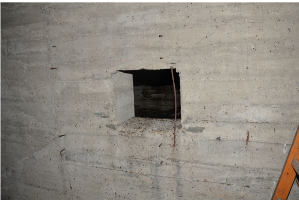
Ilustracja 5. Otwór w ścianie komory zapewniający dostęp do sąsiedniej komory.
