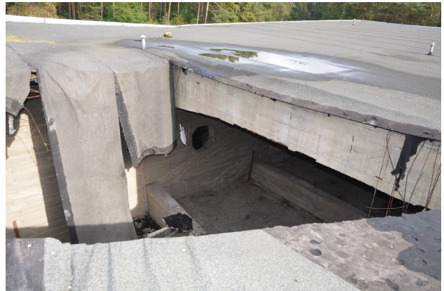
Ilustracja 12. Zawalony strop w komorze 11 – jeden z wlotów do pomnika wykorzystywanych najprawdopodobniej przez nietoperze.
