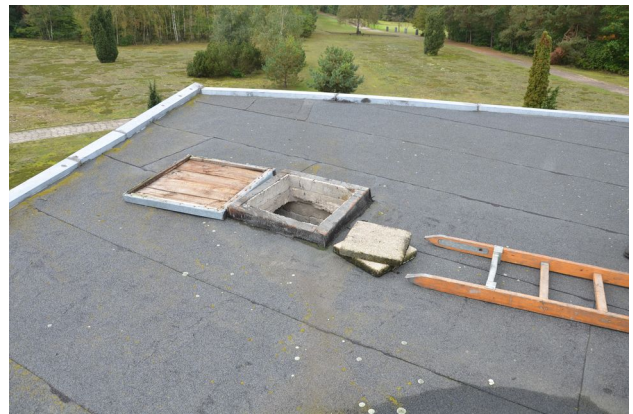
Ilustracja 6. Właz do jednej z komór.
