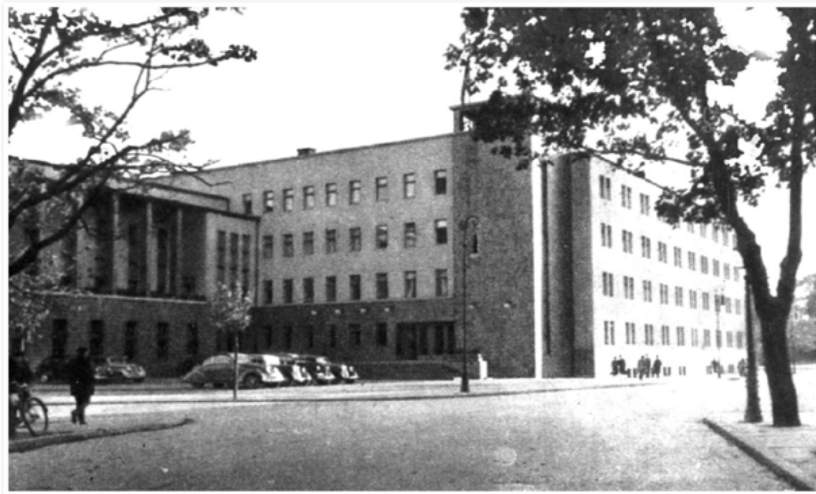
Budynek byłego Domu Żołnierza w Poznaniu. Zdjęcie wykonane w okresie okupacji hitlerowskiej 1939–1945. Zbiory Muzeum Martyrologicznego w Żabikowie
