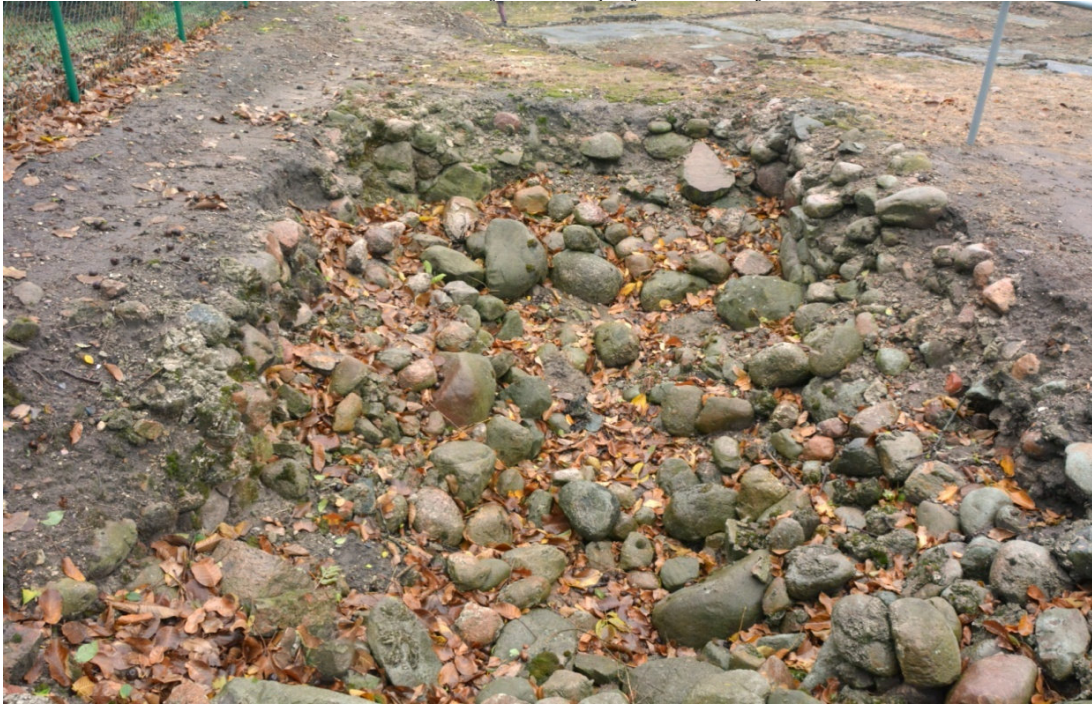
Fot. nr 37. Stan zachowania przed konserwacją.
