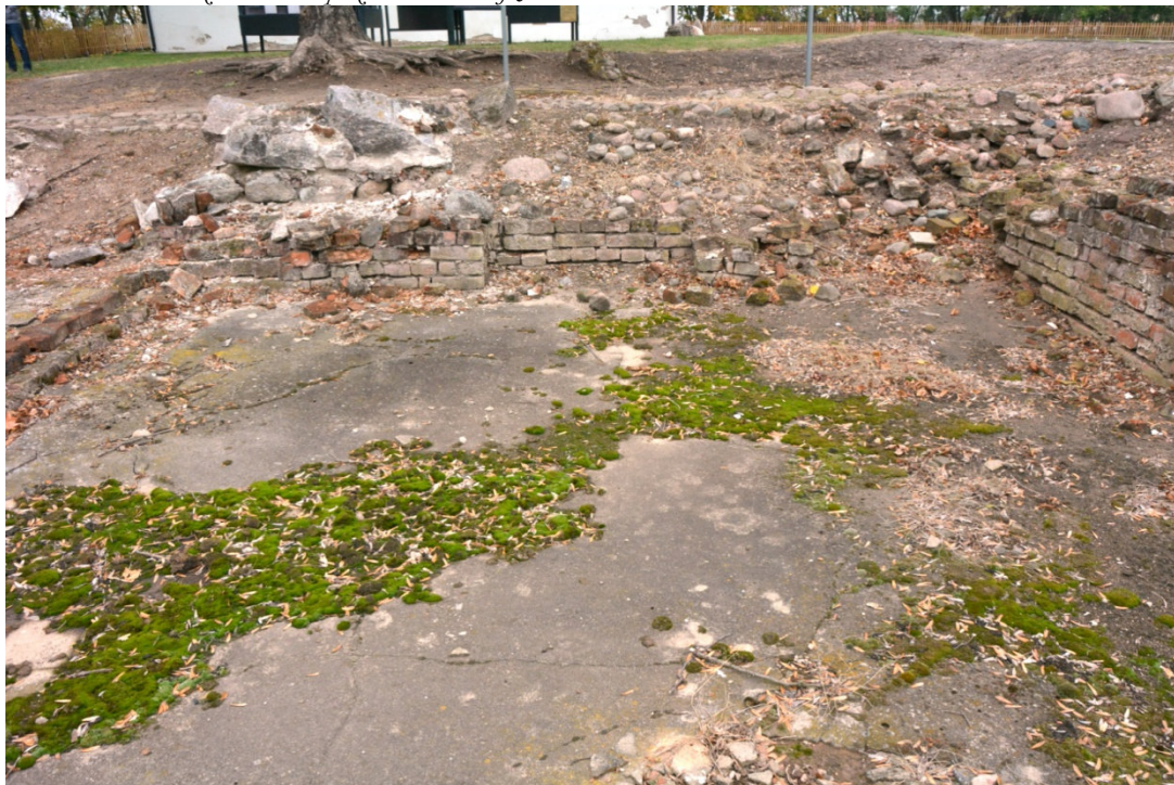
Fot. nr 14. Stan zachowania przed konserwacją.
