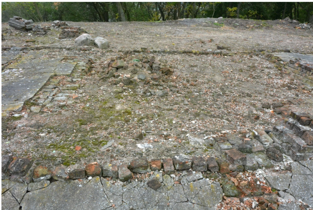
Fot. nr 29. Stan zachowania przed konserwacją.
