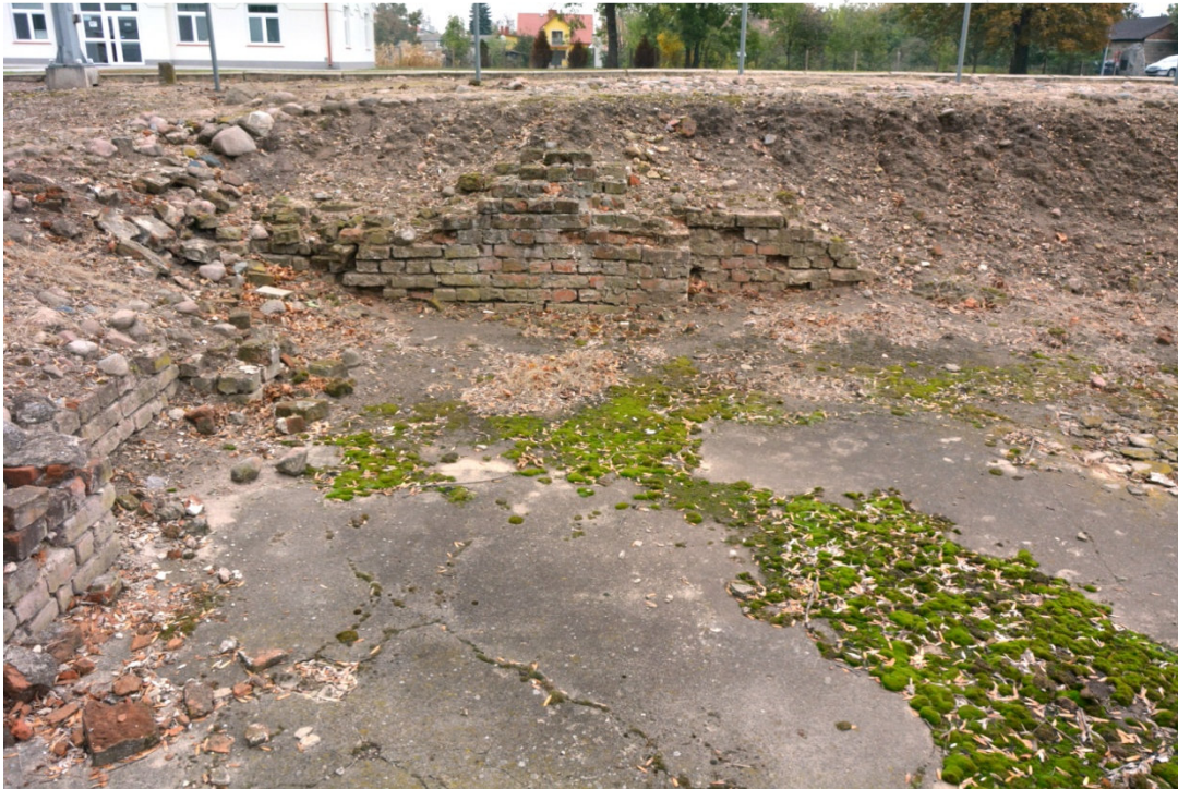
Fot. nr 15. Stan zachowania przed konserwacją.
