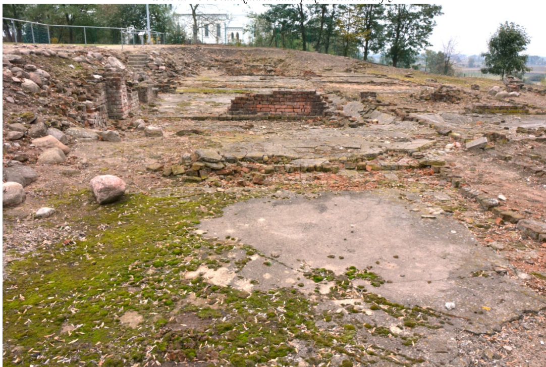
Fot. nr 16. Stan zachowania przed konserwacją.
