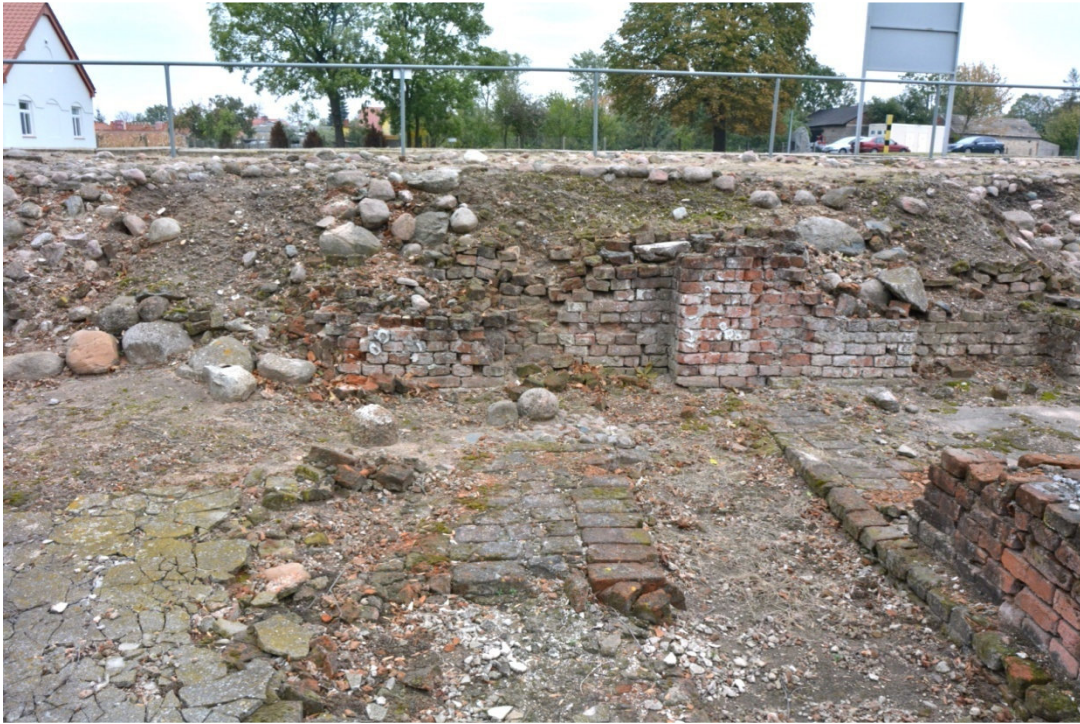
Fot. nr 18. Stan zachowania przed konserwacją.
