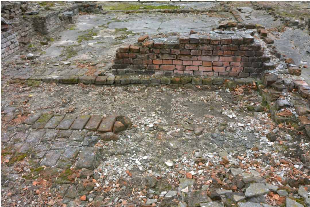
Fot. nr 19. Stan zachowania przed konserwacją.
