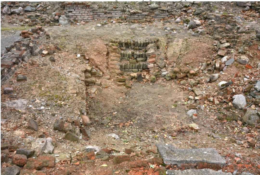
Fot. nr 26. Stan zachowania przed konserwacją.
