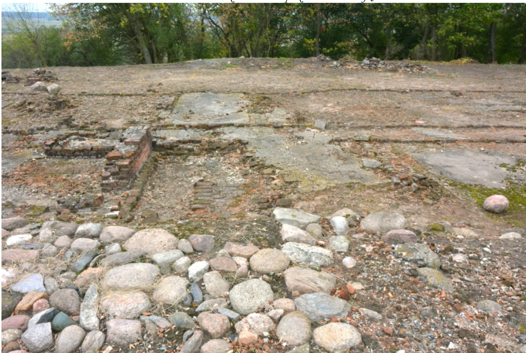
Fot. nr 10. Stan zachowania przed konserwacją.
