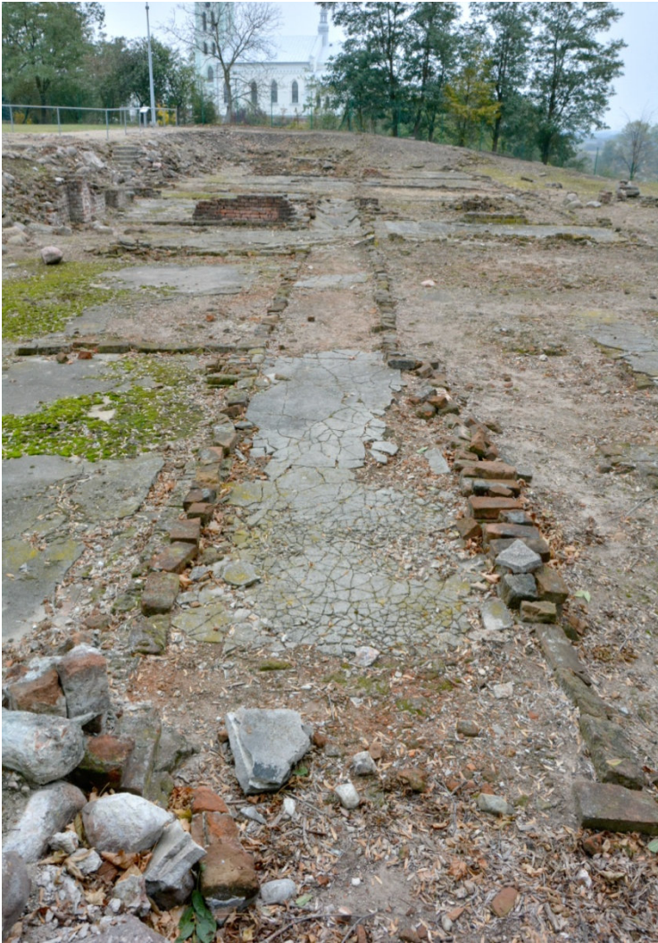
Fot. nr 13. Stan zachowania przed konserwacją.
