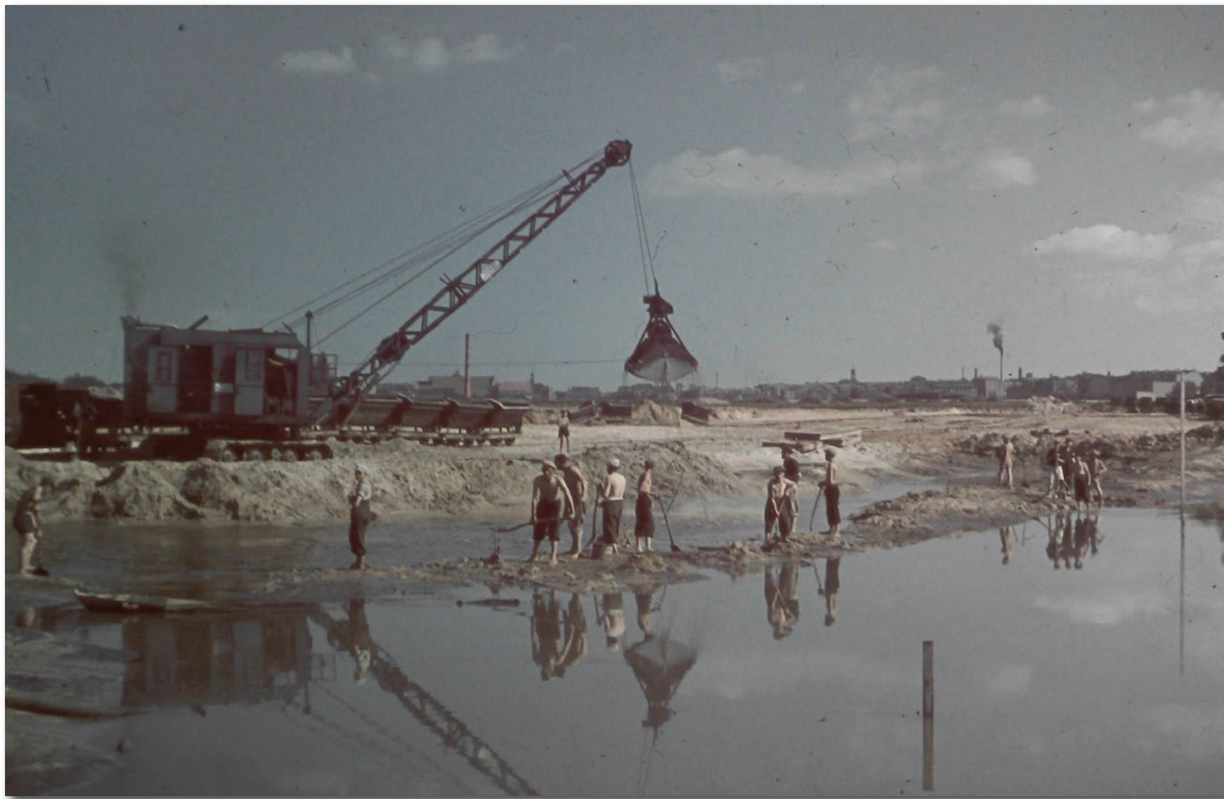
17. Prace ziemne przy budowie Jeziora Maltańskiego w Poznaniu.
