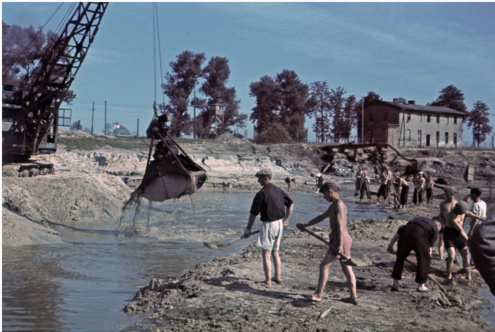
15. Prace ziemne przy budowie Jeziora Maltańskiego w Poznaniu.
